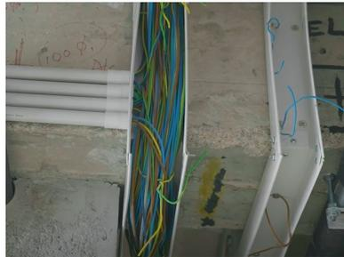
9. 電線接駁後，須用電線膠紙包好，待油漆完成後安裝掣面板
