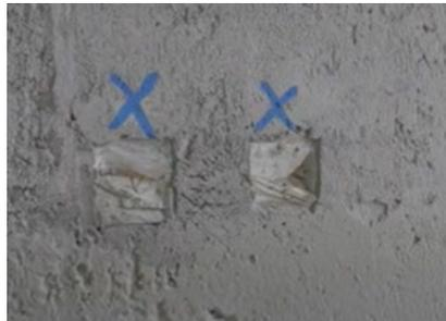
2. 水電定位須定出全屋開關插座和水路的位置。裝修師傅要根據開關插座及水龍頭的位置，在牆上劃出水管和電線的走向線（佈置線路），確認後便開始施工
