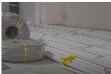
5. 新造電位，必須重新鋪設電線，情況容許下可沿用適合之舊膠燈喉
