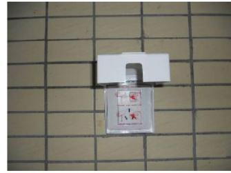
第六步 當插座需要安裝在地面時，應採用地插座類型。根據設計要求及合同要求檢查地插座的選型、安裝位置是否符合要求
