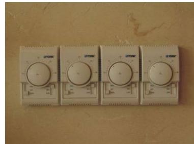
第十四步 不同類型的開關安裝在一起時，底部（或頂部）平齊在同一高度
