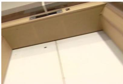
4. 交樓前，升降機已需投入操作，所以保護裝置不能妨礙操作，包括按鈕、照明設備、通風設備、閉路電視系統及逃生門
