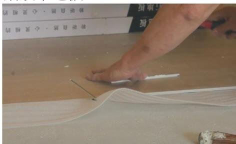
第五步 當鋪設到最後一塊的時候，按實際情況裁切合適尺寸去安裝
