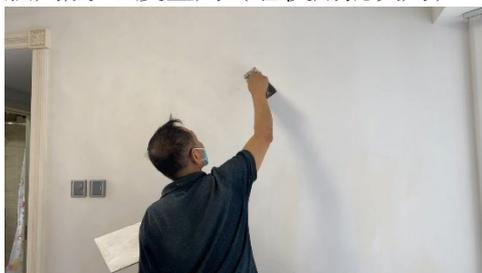
3. 檢查牆面是否有空洞開裂，可輕輕敲擊牆面，若發出實心砰砰聲時，則牆面完好
