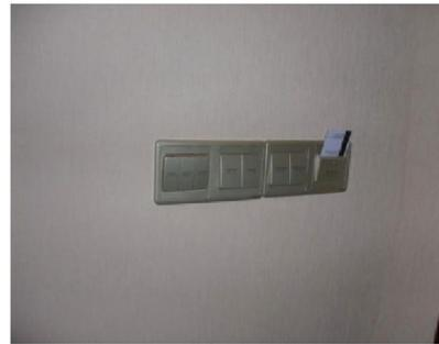
第十二步 暗裝的開關面板應緊貼牆面，四周無縫隙，安裝牢固，表面光滑整潔、無碎裂、劃傷，裝飾帽齊全
