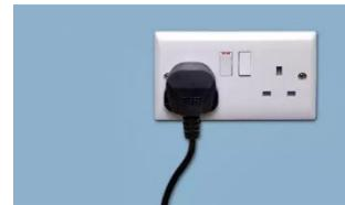
第九步 並列安裝在同一水平上的插座應盡量貼緊安裝，縫隙應小於 2mm，住宅客廳電視牆的插座安裝高度距完成地面 650mm
